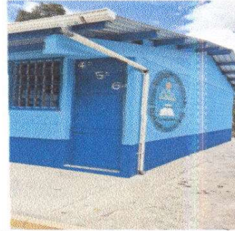
Foto 2: Sustitución de canales completos.
