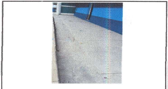
Foto 4: Reparación de planca de concreto de patio.
