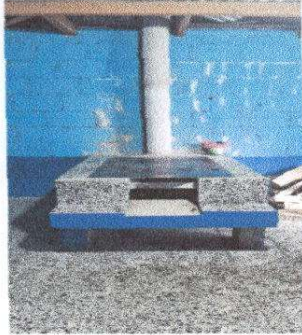
Foto1: Sustitución de estufa rural completa.
