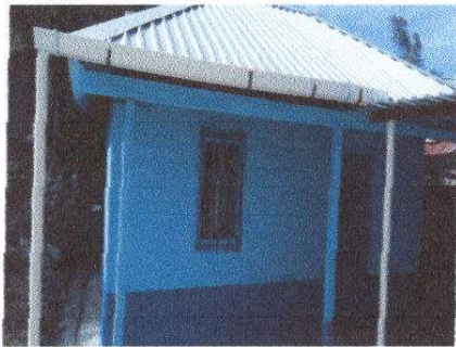
Foto 3: Sustitución de canal PVC.
