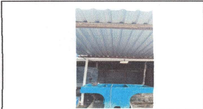
Foto1: Sustitución lámina troquelada calibre 26.
