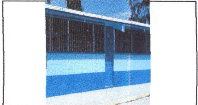
Foto 2: Sustitución de balcones de metal.
