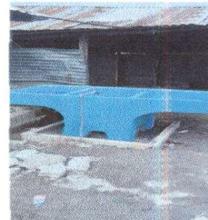
Foto 6: Sustitución de pila de cemento de dos lavaderos
