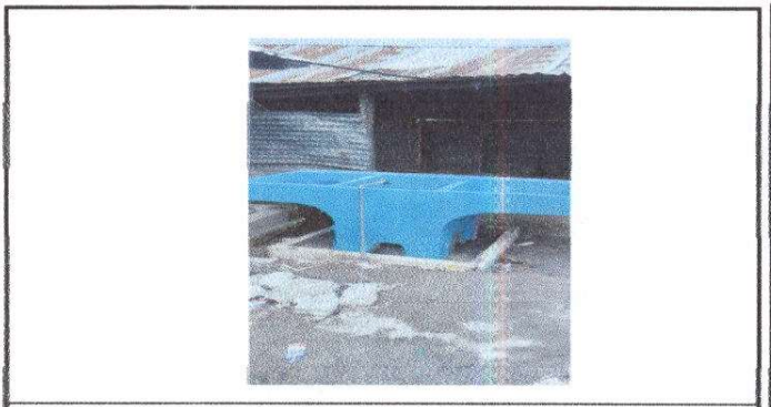
Foto 6: Sustitución de pila de cemento de dos lavaderos
